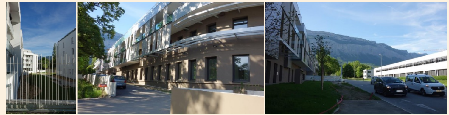
De nouvelles constructions, sans espaces verts collectifs, clos, exposées au trafic automobile
